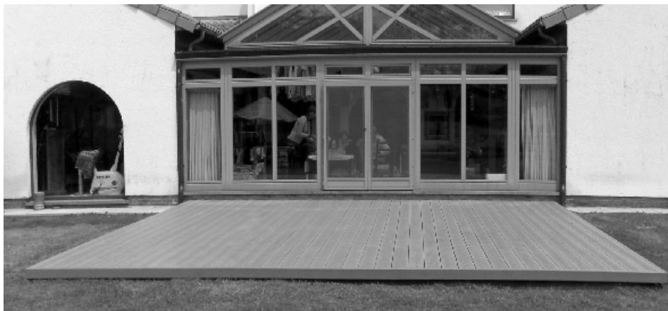
Een rechthoekig terras met afwerkingsboord. De draagstructuur is vastgezet tegen de gevel.
