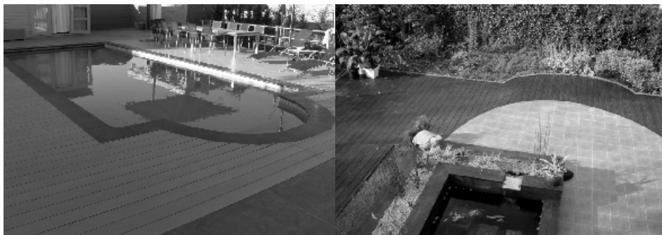
Twee voorbeelden van terrassen die verzonken liggen ( geen afwerkingsboord nodig)
